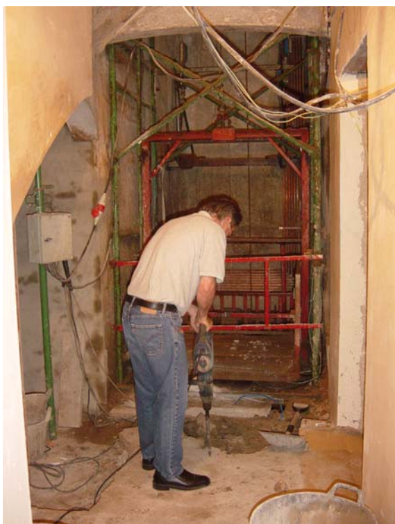
Inici dels treballs: extracció de la capa de formigó.
