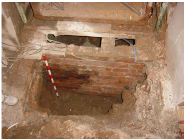
Imatge superior: finalització dels treballs
