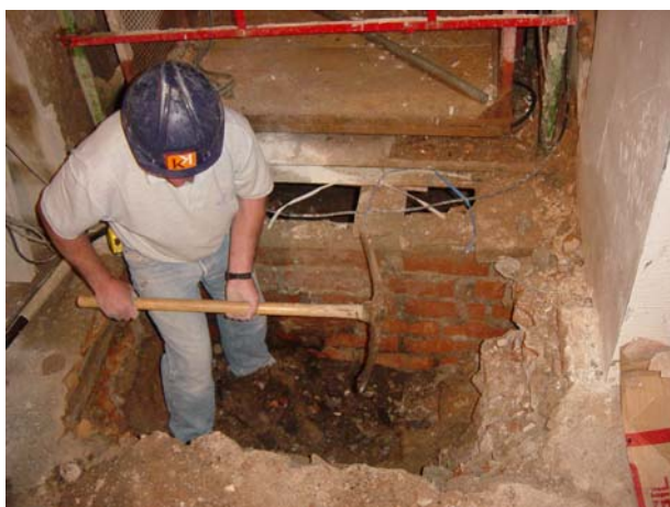
Treballs de buidatge de la cala efectuada.
